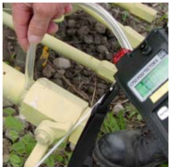
Foto 8: Screening von Armaturen mit GfG-Gerät.
